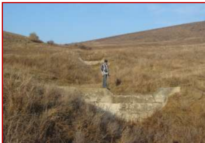
Fig. 140. Baraje din beton pe Valea Gerului (26 noiembrie 2011)
