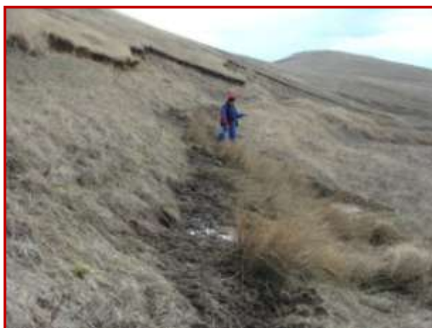
Fig. 31. Izvoare de coastă și alunecări de teren pe Valea Morii, la N de Colonești (31 martie 2012)
