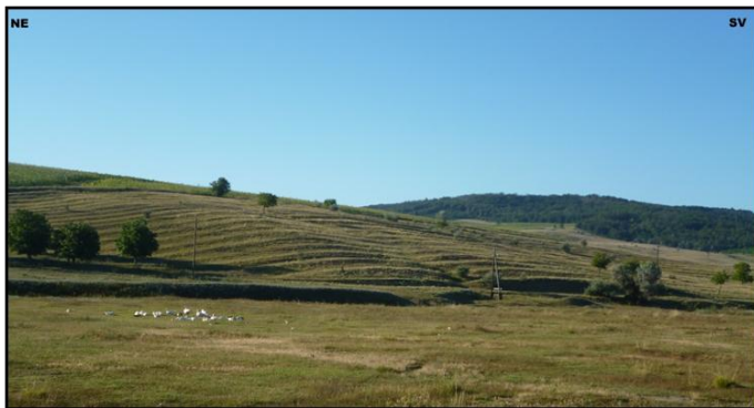
Fig. 69 Amenajare antierozională cu terase banchetă, scoasă din funcțiune la est de localitatea Tartaul
