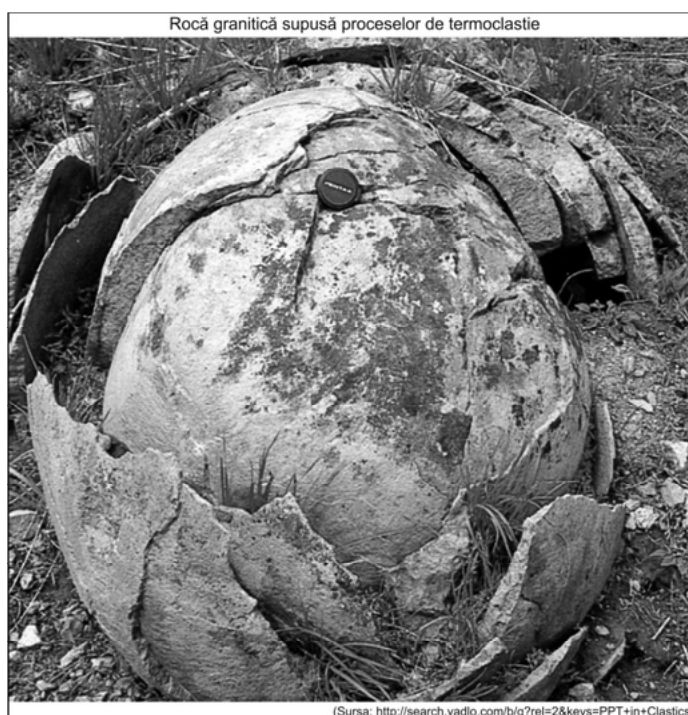
Fig. 4 - Formele specifice ale meteorizației fizico-mecanice în cazul rocilor granitice
