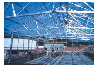
Fig.3.2. Un model de carcasă de aluminiu în construcție
