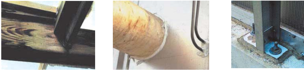
Fig. 3.5. Izolare prin sigilarea fisurilor din interiorul și exteriorul serei
